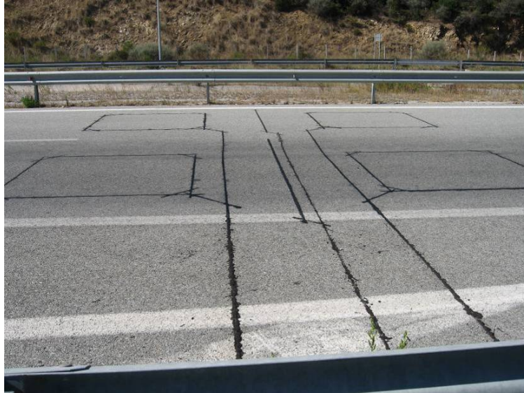
Εικόνα 1. Τυπική διάταξη βρόχων σταθμού μέτρησης κυκλοφορίας
