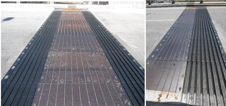
Εικόνα 1, Εικόνα 2. Φωτογραφίες των αρμών της γέφυρας
