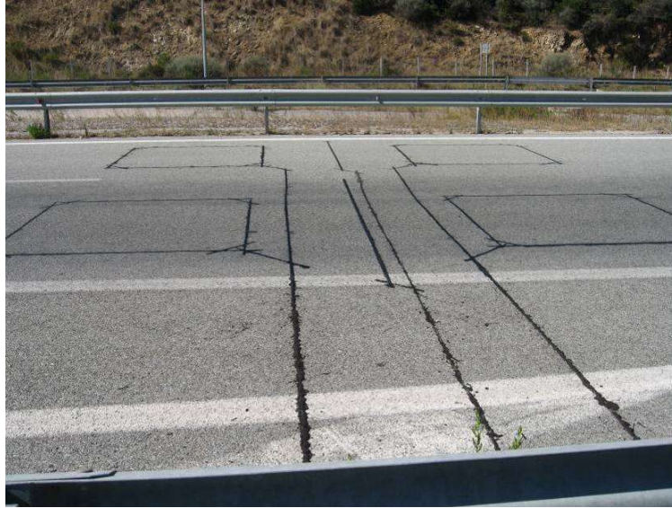
Εικόνα 1. Τυπική διάταξη βρόχων σταθμού μέτρησης κυκλοφορίας
