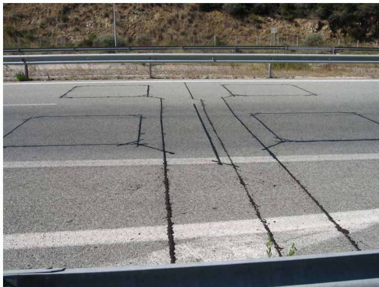
Εικόνα 1. Τυπική διάταξη βρόχων σταθμού μέτρησης κυκλοφορίας
