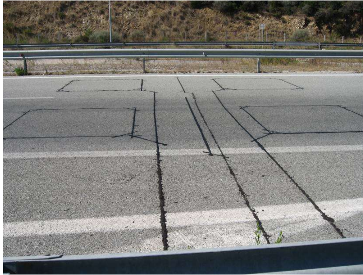
Εικόνα 1. Τυπική διάταξη βρόχων σταθμού μέτρησης κυκλοφορίας
